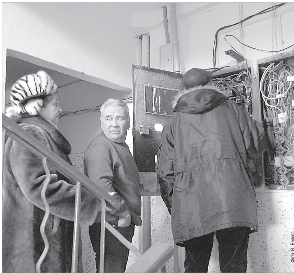
Монтер «Пермэнергосбыта» восстанавливает электросеть.
